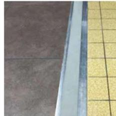
An z. B. Übergängen zu anderen Bodenbelägen verwenden Sie ein Aluminium-Rampenprofil.
